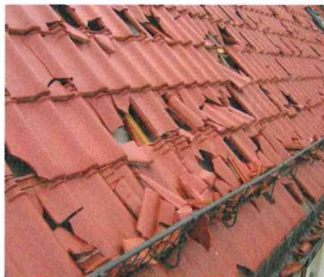
Schwere Unwetter mit starkem Hagelschlag zerstören immer wieder Tausende Dächer. Mit dem nachfolgenden Starkregen drang Wasser in die Häuser und schädigte Decken, Wände und Böden. Bauder, der Spezialist für sichere Dächer, sieht die Antwort in einem robusten Dachsystem und ließ seine Unterdeckbahnen BauderTOP und BauderPIR Wärmedämmelemente am Süddeutschen Kunststoffzentrum (SKZ) simuliertem Hagelschlag ungeschützt aussetzen.
